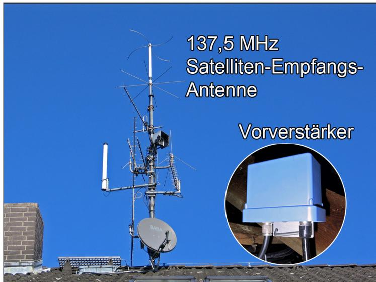
**Die Antenne an der Spitze des Mastes und der 137 MHz Vorverstärker.**
